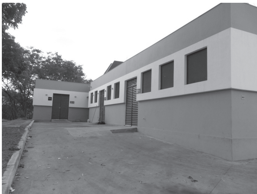
Figura 1 – Edificação para o Armazenamento Interno dos Resíduos Sólidos Coletados no Campus Coração Eucarístico da PUC Minas
